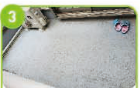
ベランダ・バルコニーの点検
